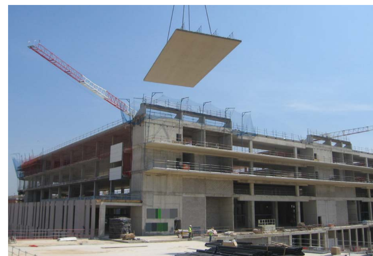
Muntatge de components industrialitzats
